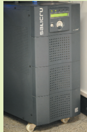
Sistema de alimentación ininterrumpida (SAI)
